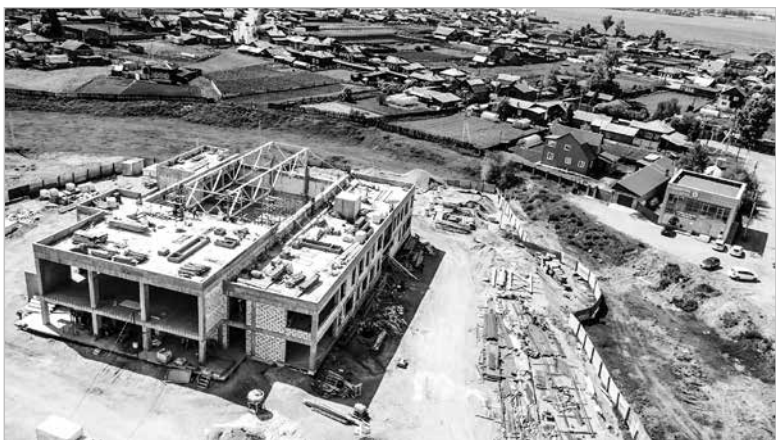
Работы по строительству нового Дома культуры в с. Хомутово идут в соответствии с графиком.
