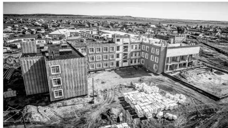
Вот так выглядит сейчас строительная площадка школы №1
