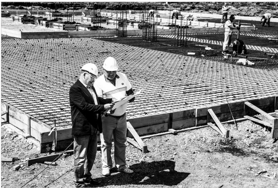
На строительной площадке – И.В. Рогов и Глава Хомутовского МО В.М. Колмаченко.
